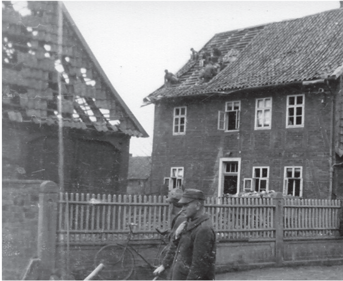
1944: Beschädigte Dächer durch Bombenabwürfe
